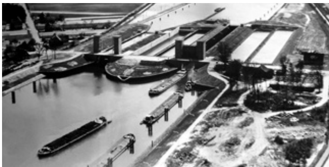
Blick auf die erneuerte und erweiterte Schleusengruppe Ende der 1950er Jahre. Quelle: Bildarchiv Heimatverein Meppen.
